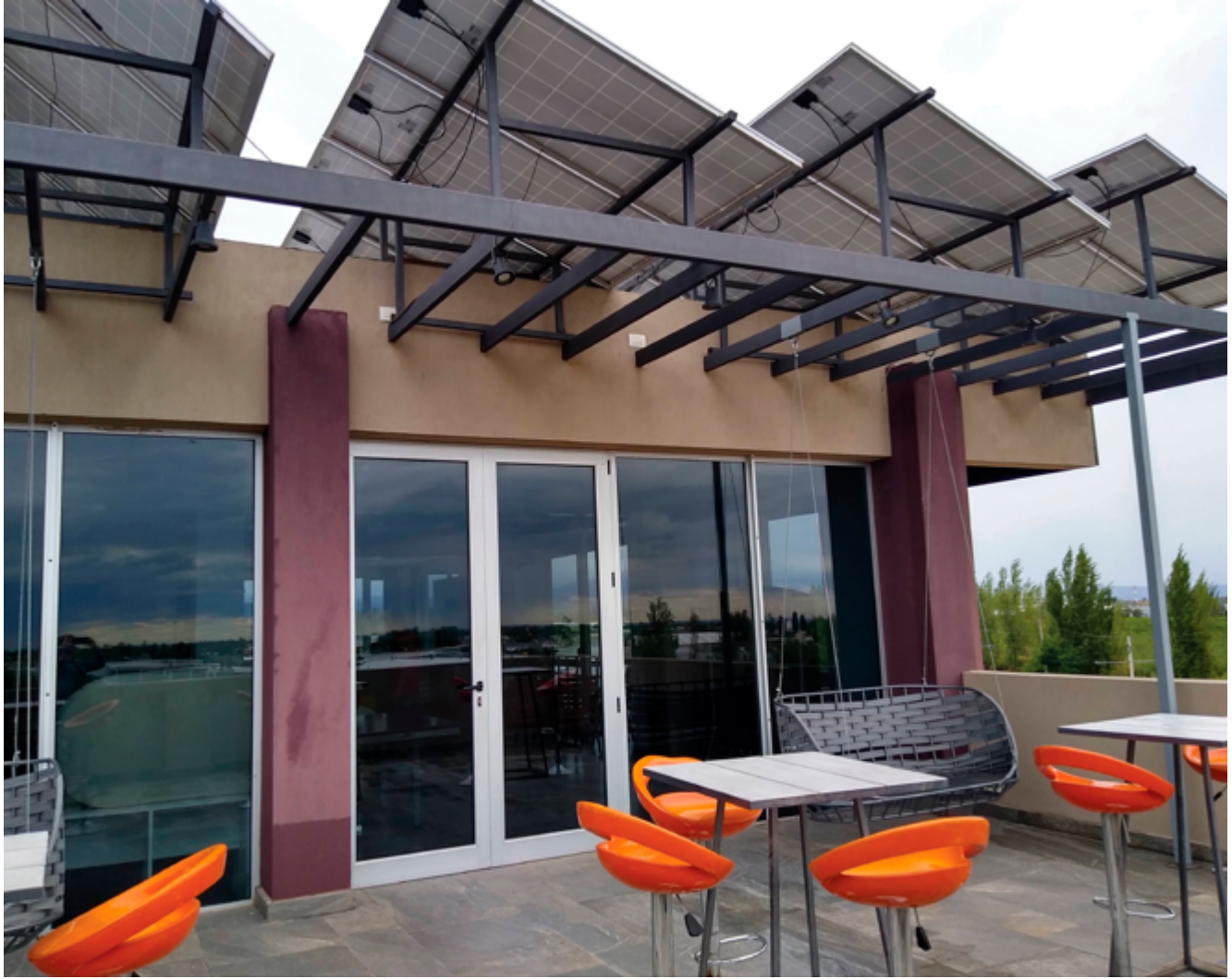
Fotografía del edificio corporativo ITC Soluciones, polo TIC Mendoza (proyecto Arq. Gustavo Llera), que cumple con los requerimientos de edificio de baja energía o casi nula ubicado en el polo industrial de la Ciudad de Mendoza, Argentina. Se observa el diseño de protecciones solares que integra paneles fotovoltaicos. Fuente: Fotografía de las autoras, 2021.
