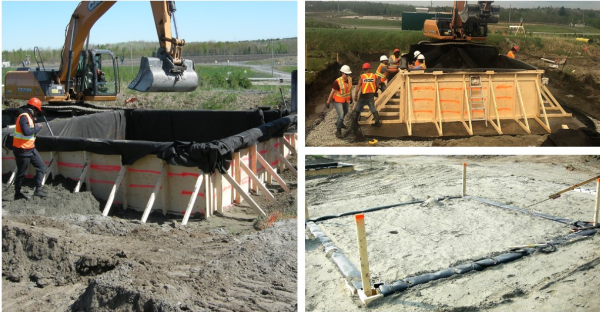
Figure 2.3-1 : Lysimètres, tel que construit
