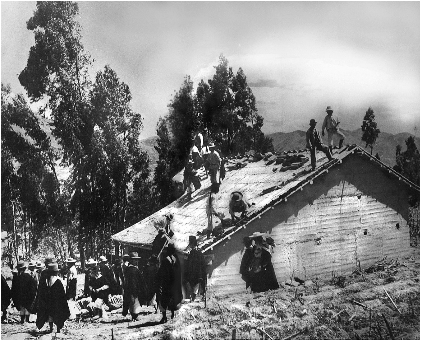
Figura 1. Trabajo colectivo para la construcción de una vivienda “moderna”.
