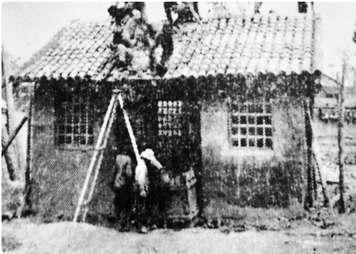
Figura 7. Techos y paredes de una casa mejorada. Fuente: MAE y CRINV, La vivienda campesina , 11.
