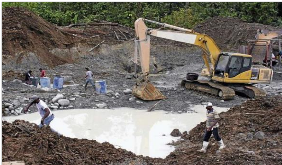
Fotografía 12. Retroexcavadora en un frente minero. Fuente: CID-PRAS: 2011.
