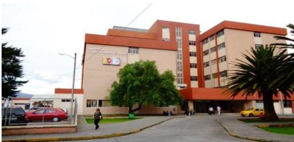
Fotografía 1. Hospital General San Vicente de Paúl Fuente: HSVP, 2017 Elaboración propia
