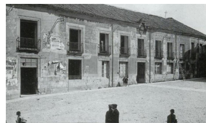
Fig.89 Casa la Lonja. Antiguo edificio de Justicia
