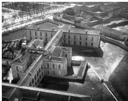
Fig93 Vista aérea del hospital. 1925
