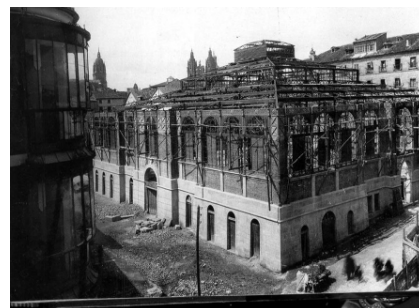
Fig.70 El mercado en construcción. Gombau
