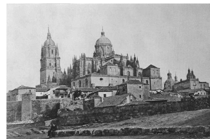
Fig. 104 Unión entre las dos cercas donde se ve la Puerta de San Pablo
