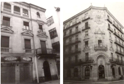
Fig.151 Edificio Valeriano Diego en Azafranal. F. Gil. 1939. Edificio Banco Santander. F. Gil. 1940 135. COAS, memoria expediente 2123
