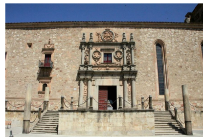
Fig. 162 Fachada del Colegio Mayor de Santiago
