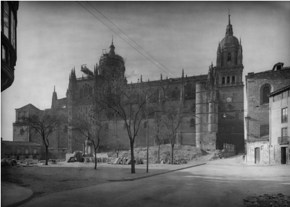
Fig. 41 Obras en la plaza. Muller Grossmann. 1955
