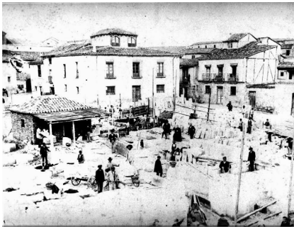
Fig.82 La construcción de los cimientos de la iglesias. Padre Cámara junto a Vargas Repulles.
