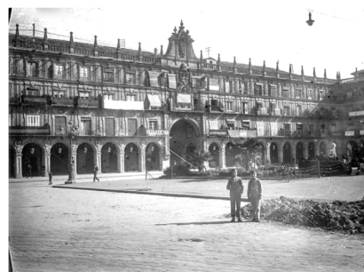
Fig. 156 La Plaza en obras
