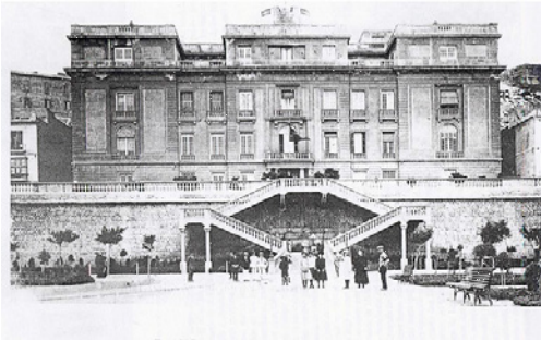
Figura 6. Escalera monumental entre el Paseo de Alfonso XII y la Muralla del Mar; transformación del elemento castrense en belvedere urbano sobre el puerto.
