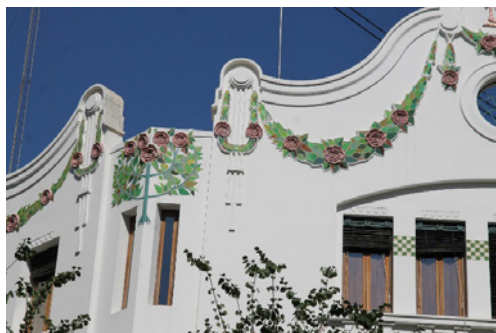
Fig. 7 y 8. Detalles Casa Ferrer, 1908. Arquitecto: Vicente Ferrer Pérez. Situación: c/ Cirilo Amorós 29 y c/Pizarro 16. Fuente propia de los autores.
