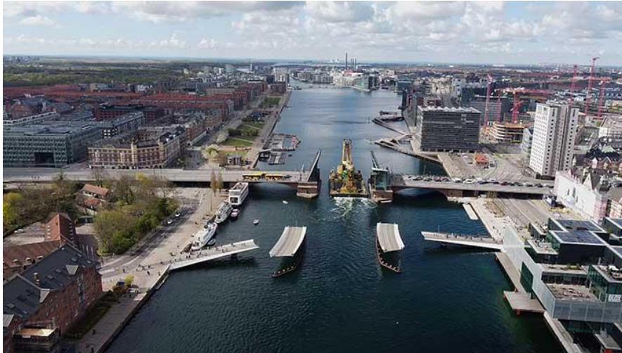
Fig. 2.4.2.1: Motor MAN de dos tiempos siendo trasladado al centro de investigación de MAN Energy Solutions en Copenhague para ser adaptado al consumo de amoníaco. (Lindstrand, 2021)
