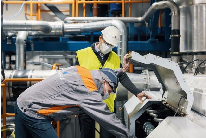
Fig. 2.4.1.1: Técnicos de la casa Wärtsilä trabajando en un motor de 4 tiempos que consume amoníaco mezclado con combustibles promotores de llama. (Wärtsilä Corporation, 2022)
