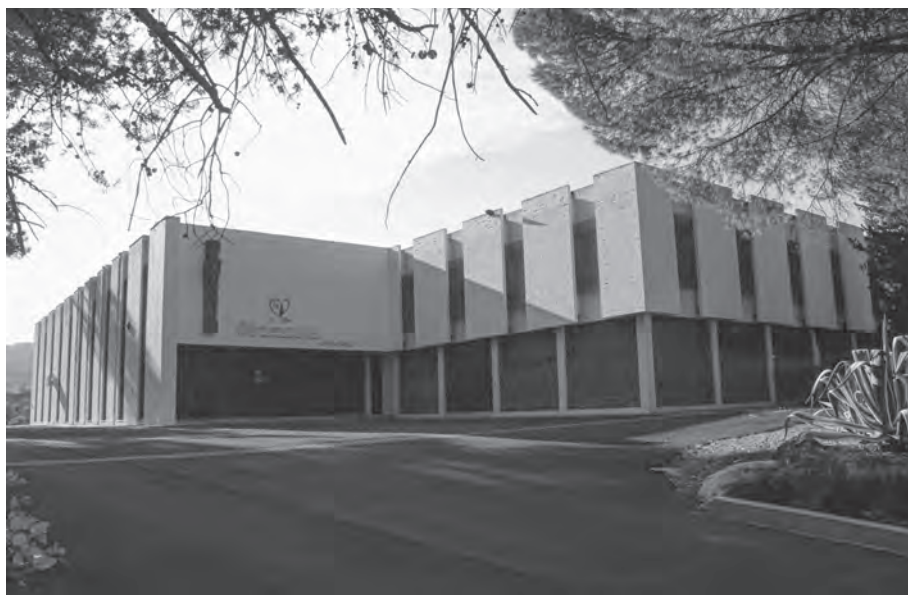
Fig. 4. Edificio 03. Monasterio de Las Salesas. Zona de acceso principal al edificio.
