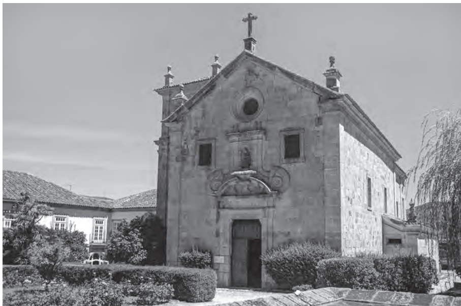
Fig. 10. Mosteiro de S. Pedro Águas-o-Novo. Alçado Principal da Igreja (2018).
