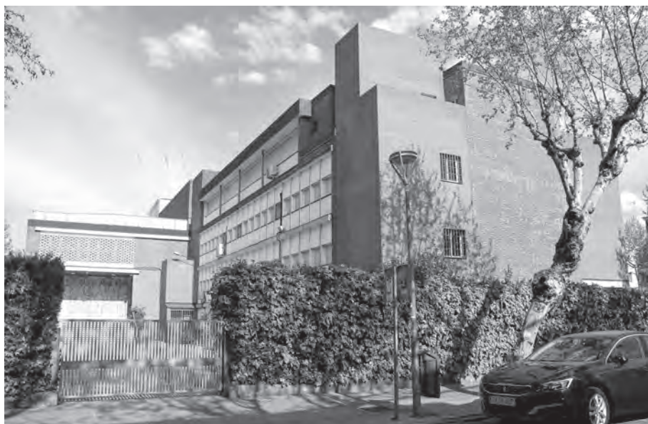
Fig. 1. Edificio 01. Residencia de las Hijas de María Inmaculada. Zona de acceso a la capilla. Fuente: Fotografía de los autores, 2019.
