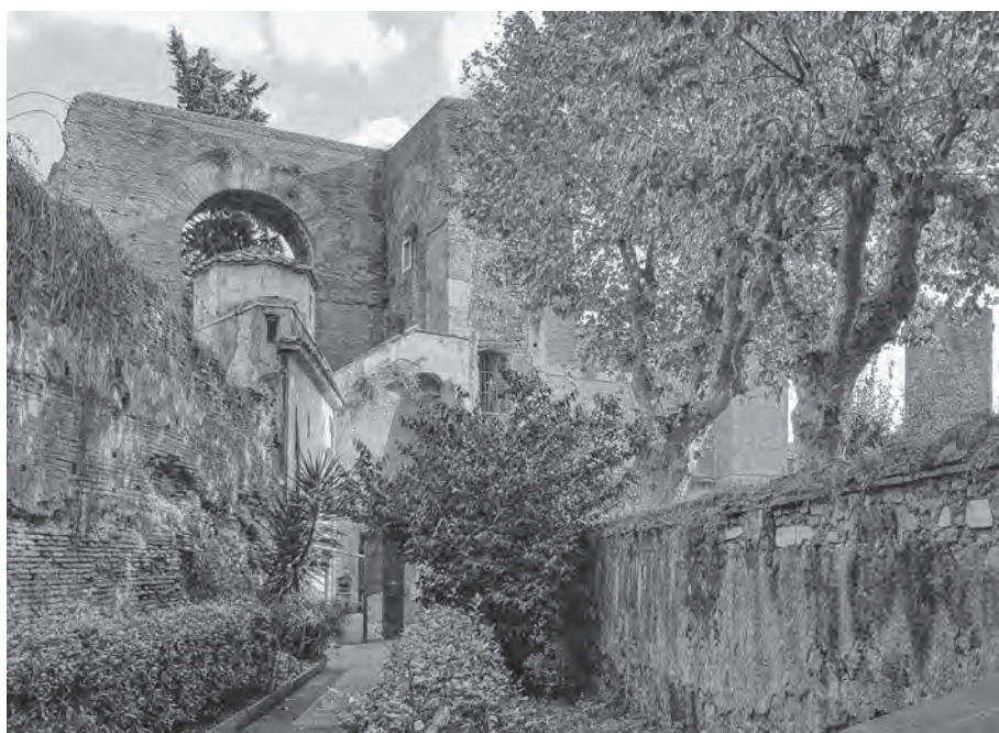
Fig. 3. Interior del complejo, restos del acueducto vistos desde la iglesia. Fotografía de los autores.
