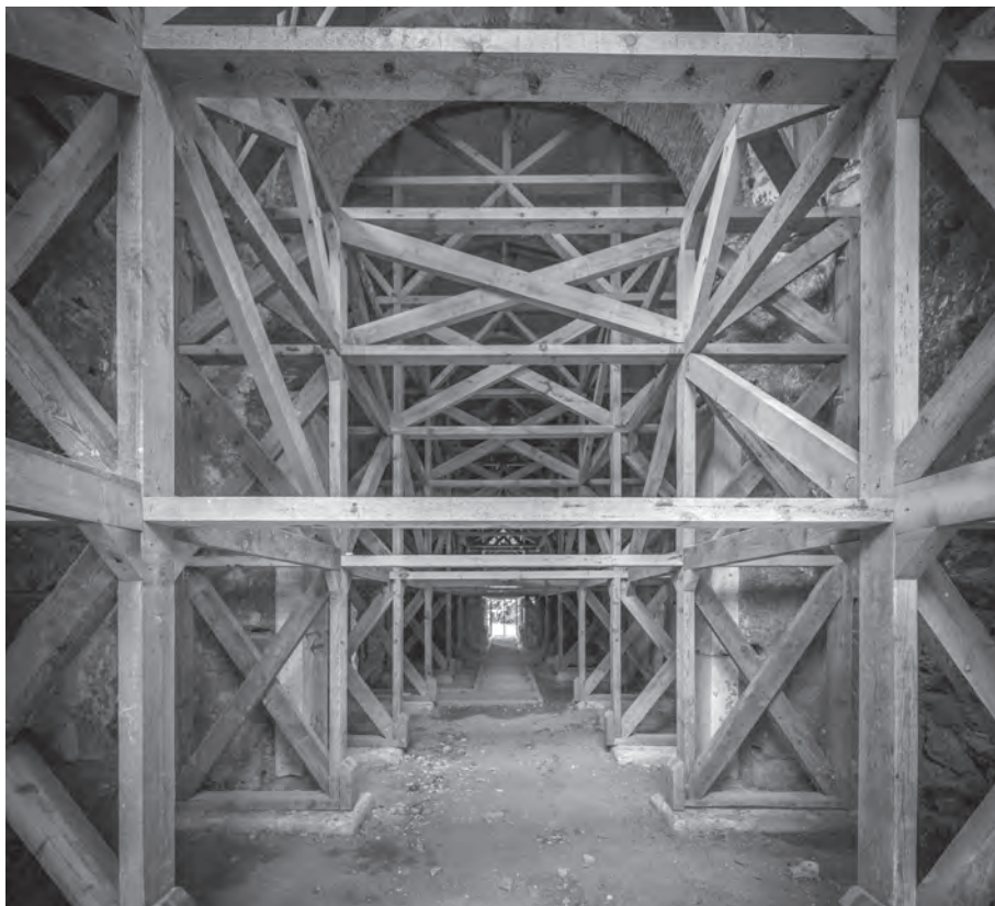
Fig. 8. Obra em curso: circuito de visita em segurança por entre estruturas de sustentação (2016). Fonte: José Manuel.
