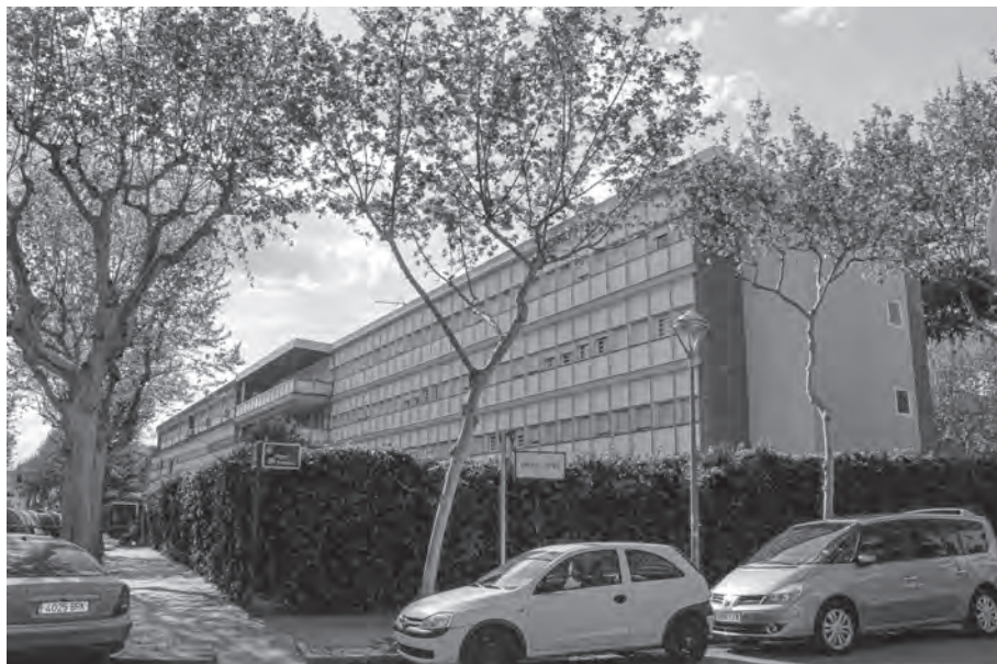
Fig. 2. Edificio 01. Residencia de las Hijas de María Inmaculada. Fuente: Fotografía de los autores, 2019.
