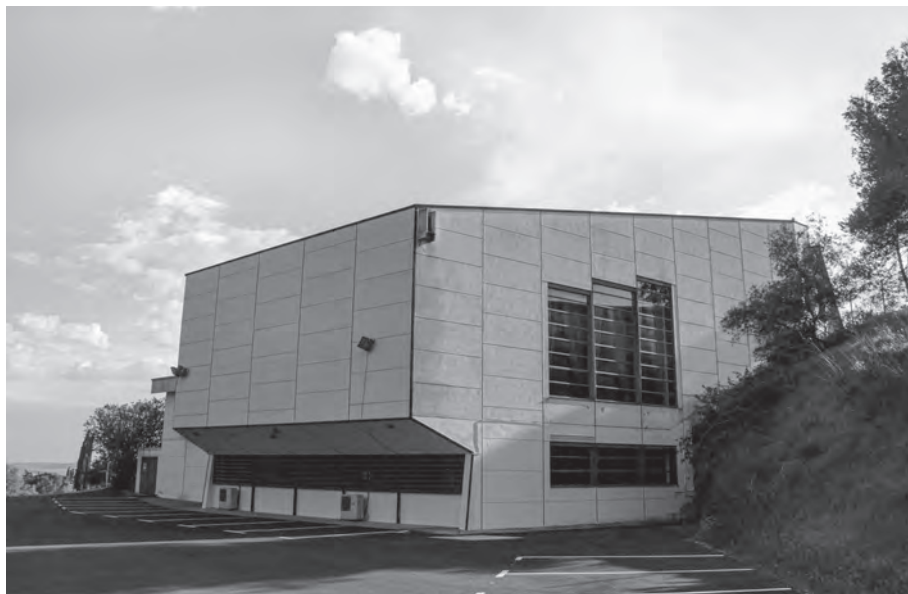
Fig. 5. Edificio 04. Casa de Cursillos San Pablo. Volumen exterior de la Capilla. Fuente: Fotografía de los autores, 2019.
