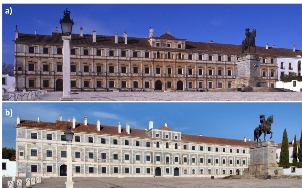
Figure 1. Façade of the Paço Ducal de Vila Viçosa (Portugal): (a) before and (b) after the cleaning intervention (©Fundação da Casa de Bragança).
