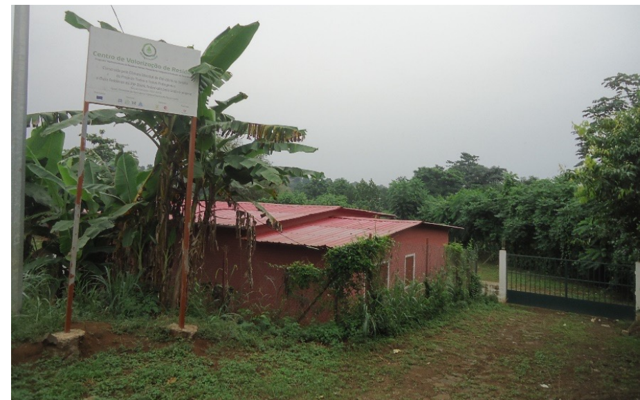
Figura 27. Centro de Valorização de Resíduos. (Lugar de Correia, janeiro 2021)
