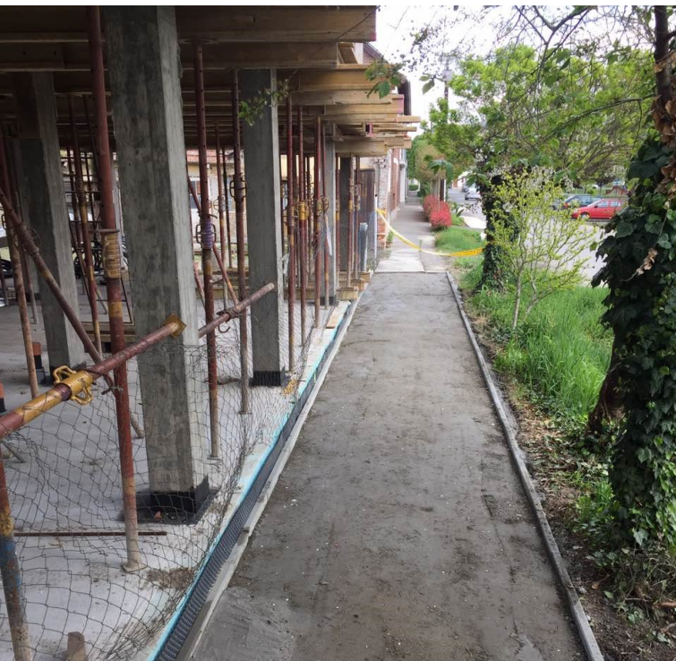
42. ábra: Pillérvázás szerkezeti rendszer a polgári lakóháznál (fotó: Sódar Norbert)
