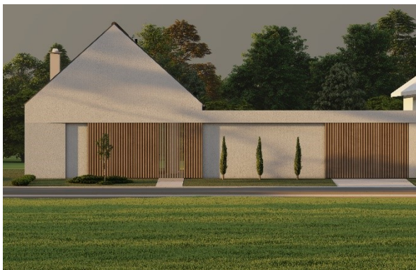
36. ábra: A bordányi ház zárt kerítéssel (render fotó: Sódar Norbert)
