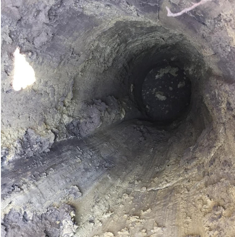
40. ábra: Cölöpalap furata a Mátyás téri polgári háznál (fotó: Sódar Norbert)
