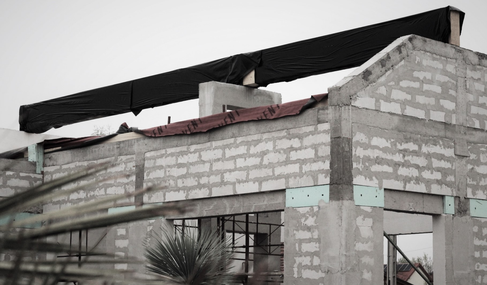
34. ábra: A tápéi ház építés közben (fotó: Sódar Norbert)
