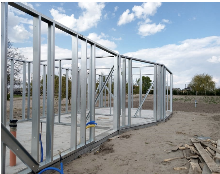
38. ábra: A bordányi ház vázszerkezete (fotó Sódar Norbert)
