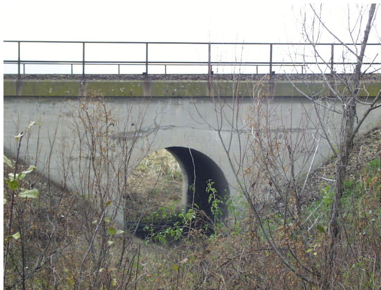
Image 1: The view of the Szerencs bridge
