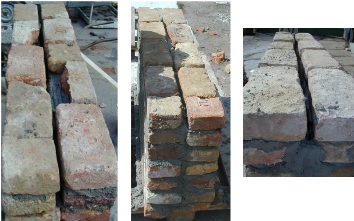
Photo 4. Construction of F1 test wall
