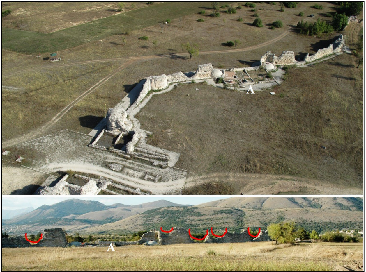
Figura 3. Le fortificazioni occidentali da sud, ripresa da pallone. In alto, la porta ovest e il settore murario musealizzato. In basso, evidenziazione del crollo festonato delle mura causato da sisma. La A indica le strutture residuali del monastero appoggiato alle mura (foto A. Blanco e D. Nepi).
