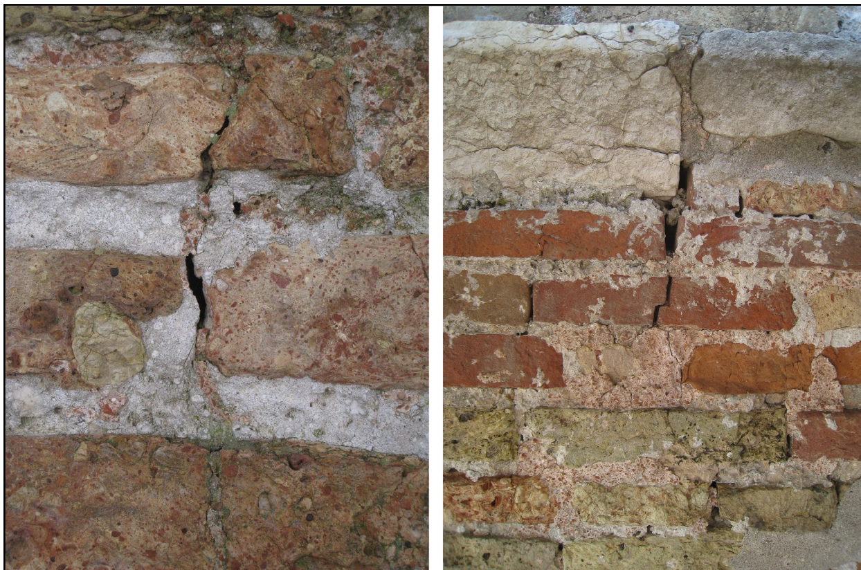
Figura 2. Riparazioni in cocchiopesto (rosato) di antiche lesioni riscontrate sul fusto del campanile di Sant'Aponal (foto di F. Doglioni su concessione dell'autore).
