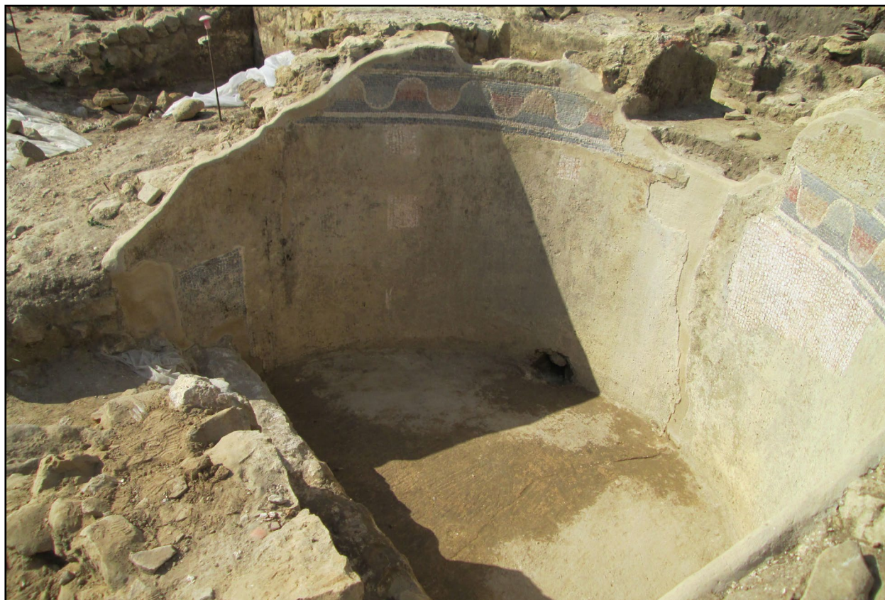
Figura 3. Crepa lungo la parete e sul piano della vasca absidata nel frigidarium (foto D. Piay Augusto).
