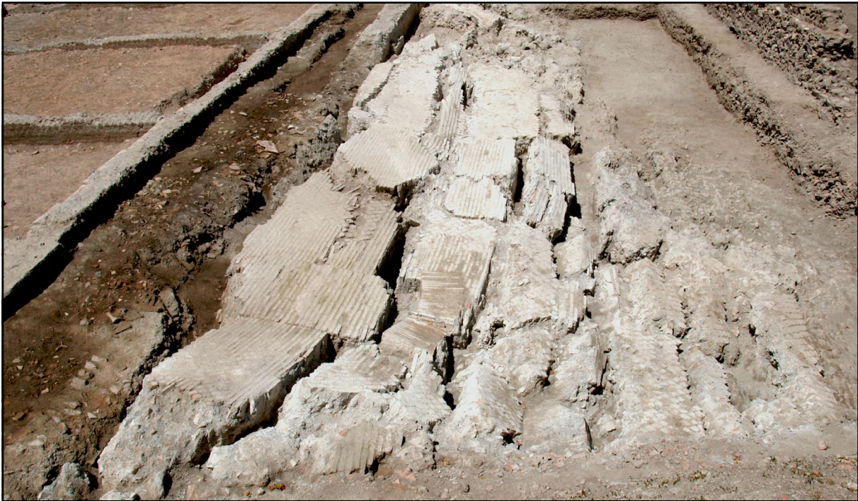
Figura 2. Testaccio. Struttura al confine orientale dell'area scavata crollata per effetto del sisma del 443 d.C. (foto S. Festuccia).
