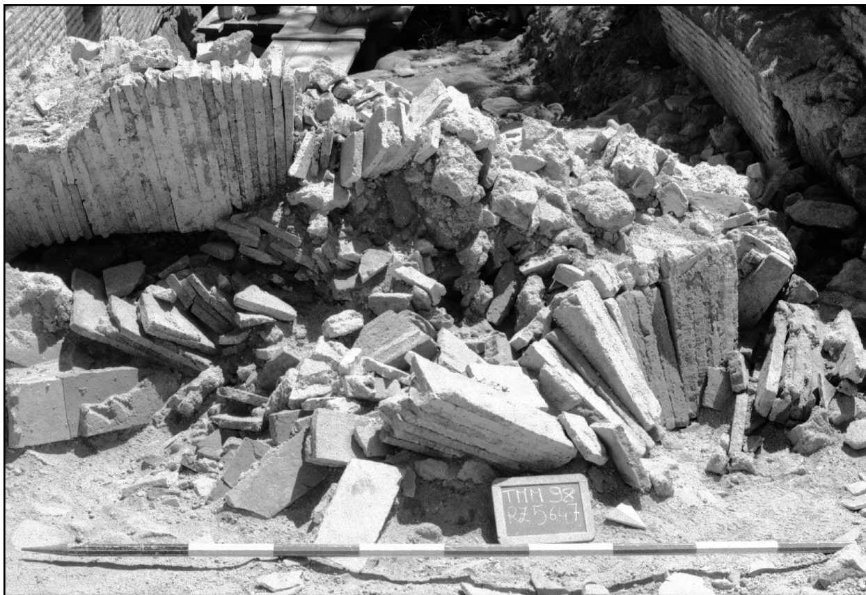
Figura 5. Palatino. Fullonica est: arco di sostegno della volta crollato e non rimosso per il sisma del 484 o del 508 d.C. (foto F. Coletti).
