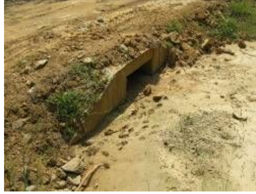
Şekil 6: Beş numaralı menfezin giriş kısmının durumu
