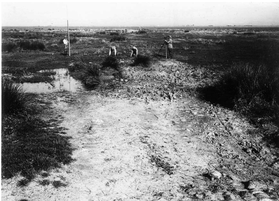
Fig. 3. Sicilia, Piana di Catania: attività di rilievo topografico preliminari alla bonifica di età fascista (Archivio del Consorzio della Bonifica di Catania).
