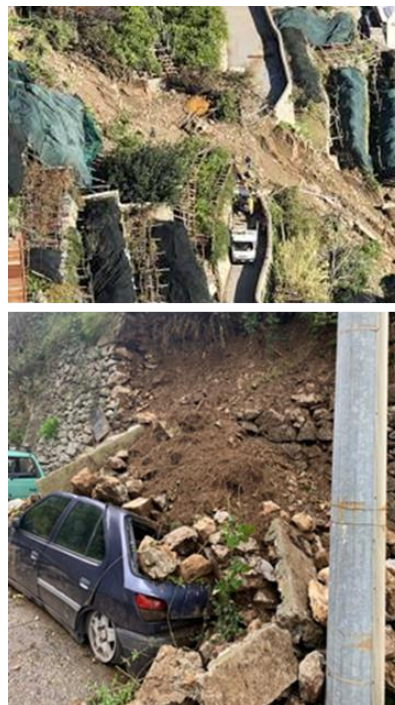
Figura 5 – Crolli di muri a secco a seguito delle piogge intense del 20 e 21/12/2019.
