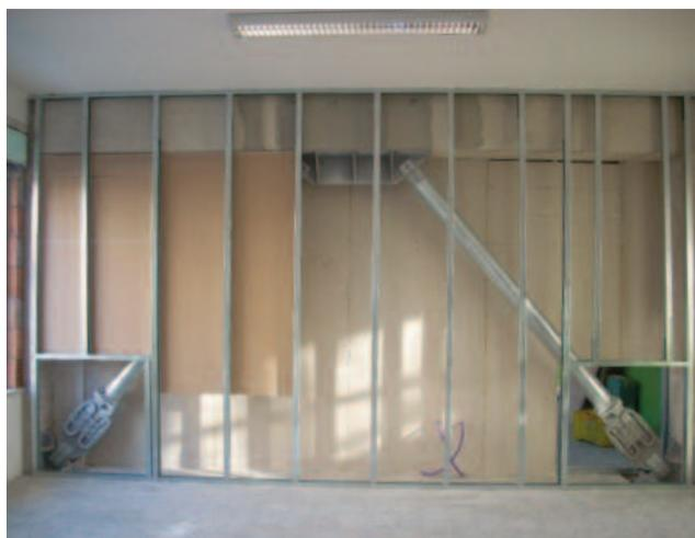
Fig. 2. Adeguamento sismico di un edificio scolastico in calcestruzzo armato mediante controventi dissipativi parzialmente lasciati a vista (Liceo Statale *Vito Capialbi* a Vibo Valentia).
