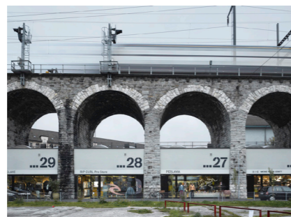
Fig. 53 Fotografia de la façana del viaducte. Font externa.
