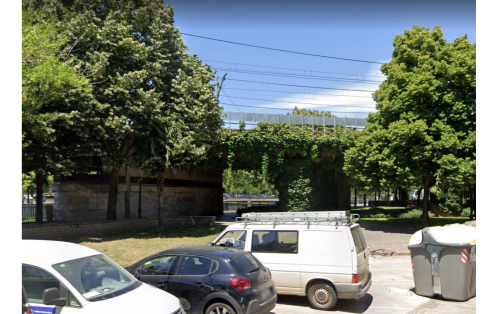
Fig. 38 Fotografia del viaducte des del carrer d'En Jaume Pons Martí. Font externa
