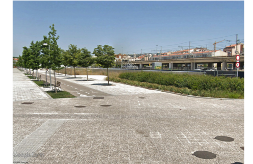
Fig. 17 Fotografia del viaducte des del passeig d'Olot. Font externa
