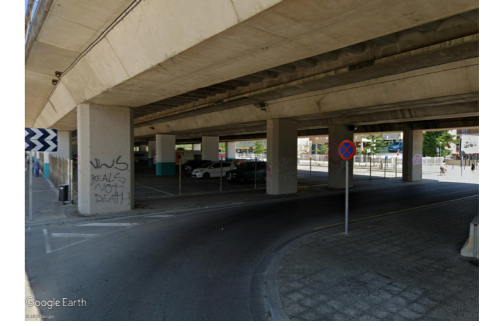
Fig. 16 Fotografia del viaducte des del carrer Josep Maria Gironella i Pous. Font externa
