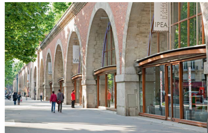
Fig. 106 Fotografia de la façana del viaducte Font externa
