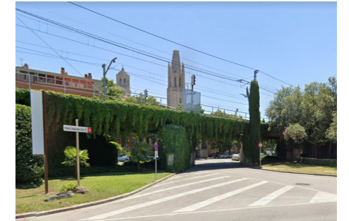
Fig. 37 Fotografia del viaducte des del carrer de Palamós. Font externa
