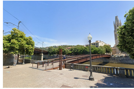
Fig. 32 Fotografia del viaducte des del carrer José Canalejas. Font externa
