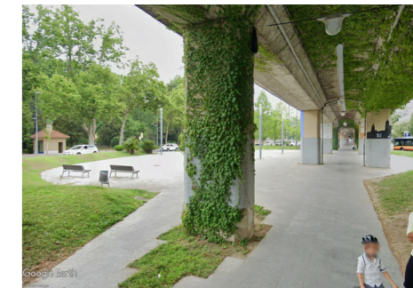
Fig. 26 Fotografia del viaducte des de la rotonda del Rellotge. Font externa
