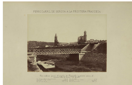
Fig. 4 Imatge del terraplè de la línia de ferrocarril amb la catedral al fons. 1880
