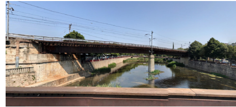
Fig. 33 Fotografia del viaducte des del pont de Sant Feliu. Font externa
