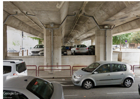
Fig. 10 Fotografia del viaducte des del carrer Cassià Costal. Font externa
