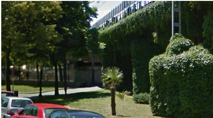
Fig. 121 Fotografia del viaducte des del carrer d'En Jaume Pons Martí. Font externa
