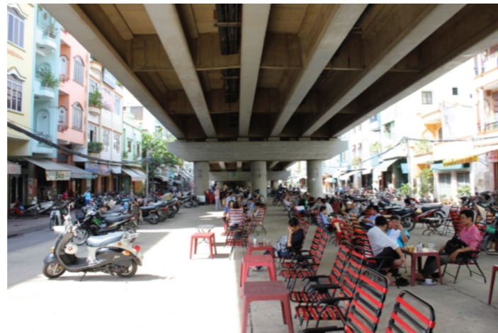
Fig. 83 Fotografia de l'espai sota el viaducte Font externa
