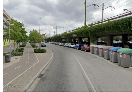
Fig. 11 Fotografia del viaducte des del carrer Josep Maria Gironella i Pous. Font externa
