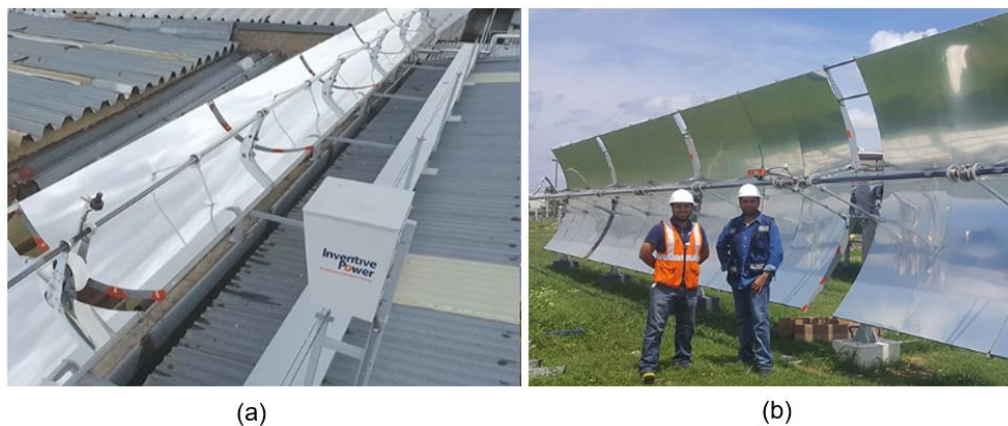
Figura 12. Sistemas instalados en la industria alimenticia: (a) Power Trough 110® - proceso de pasteurización y (b) Power Trough 250® - calentamiento de aceite vegetal (Inventive Power, 2018a).
