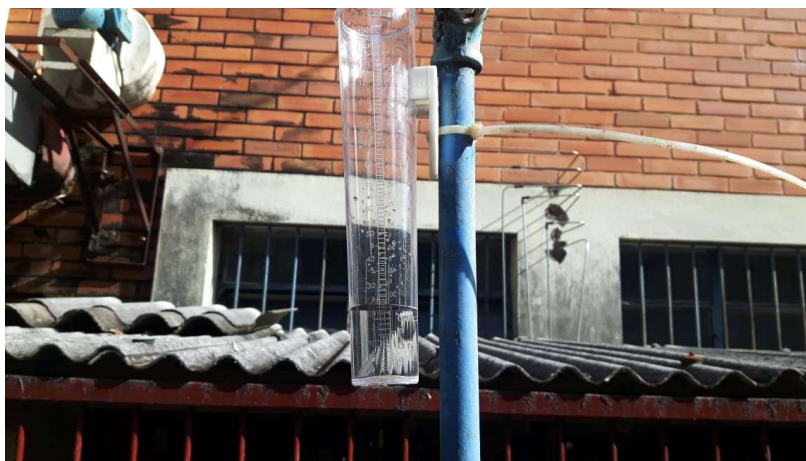
Figura 13: Pluviômetro instalado no Centro de Tecnologia
