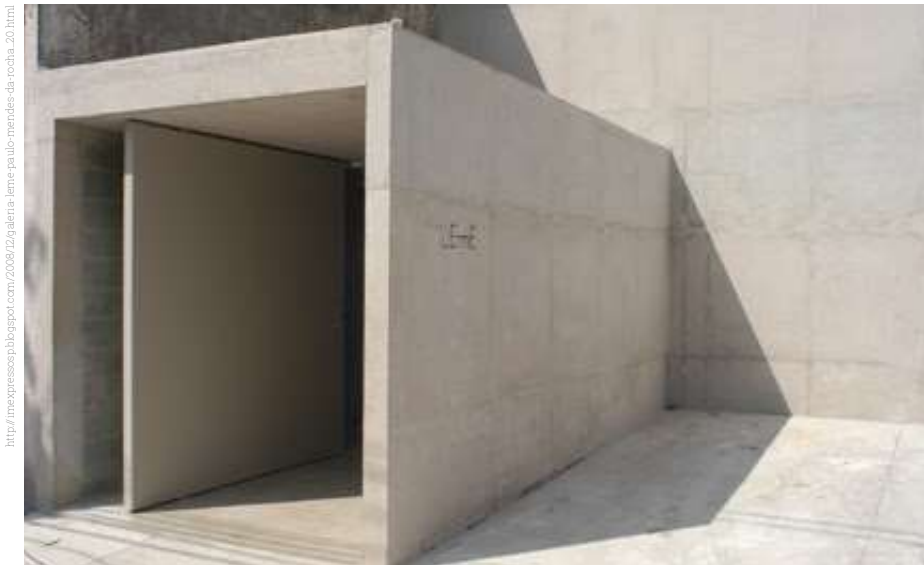
Pórtico de acesso à primeira versão da Galeria Leme.
