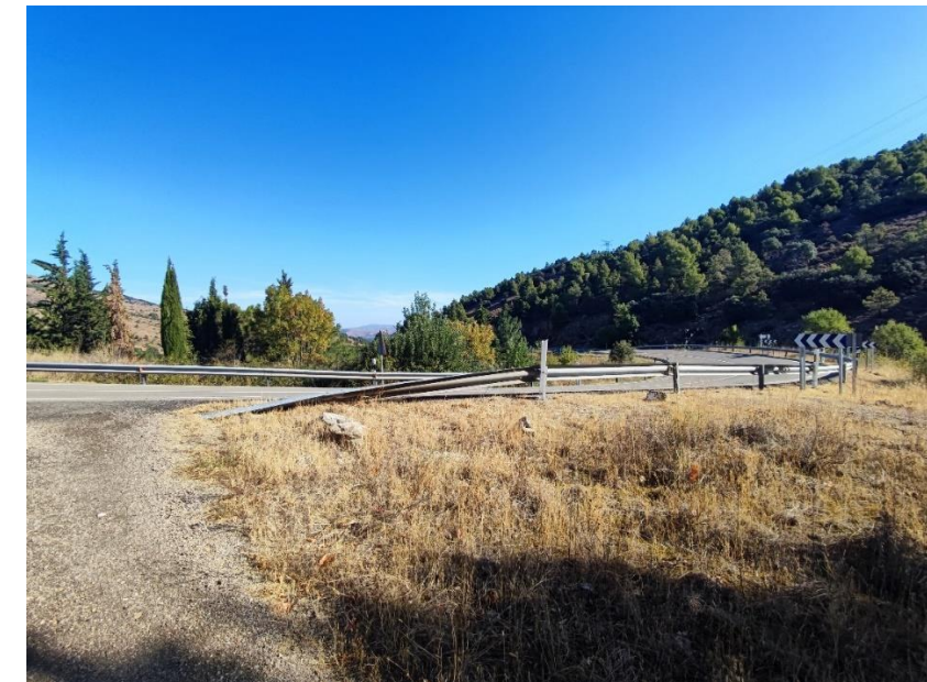
Ilustración 1. Curvas cerradas en la carretera existente.
