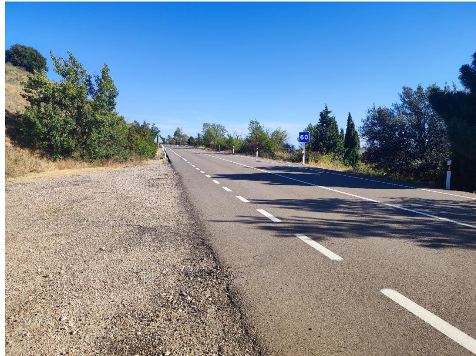
Ilustración 6. Se puede apreciar un buen estado de conservación de la capa de rodadura, las marcas viales son notorias y cuenta con hitos miriamétricos. Se aprecia una señal de recomendación de velocidad siendo que la velocidad de la carretera es de 80 km/h.
