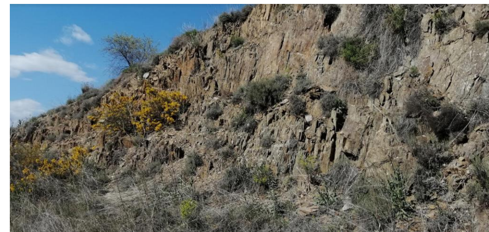
Imagen N°15. Zona de trabajo de la primera estación geomecánica. (pizarras)
