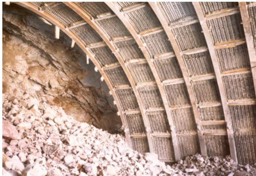
Ilustración 3. Ejecución de túnel por método bernold.
