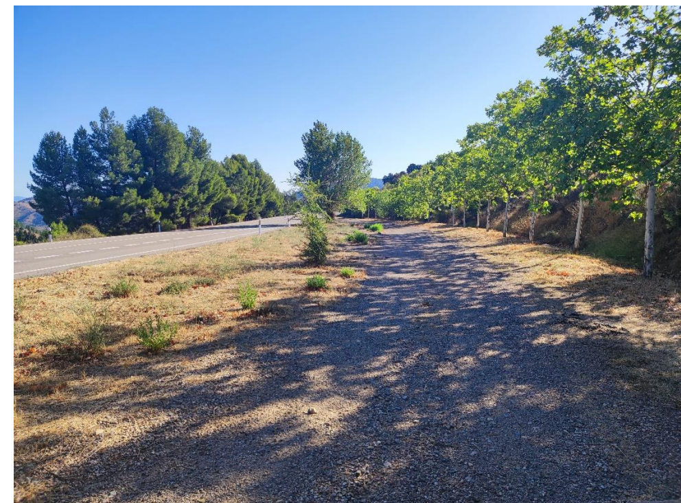
Ilustración 5. Restos del trazado original de la N-II cuando se construyó por primera vez. Se encuentran muchos de estos a lo largo de la carretera actual.
