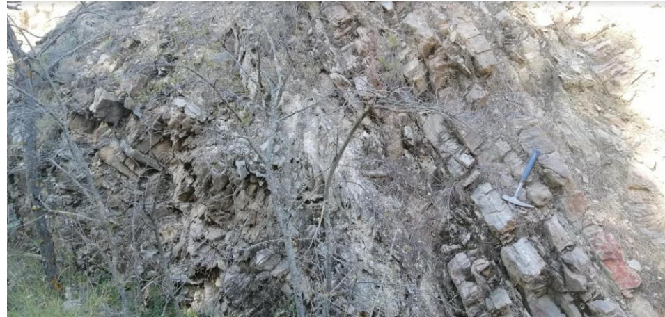
Imagen N°16. Zona de trabajo de la segunda estación geomecánica. (limolitas)
