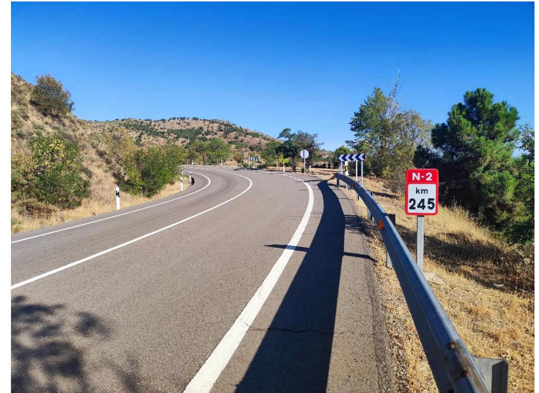
Ilustración 8. Los elementos de la carretera se encuentran en buen estado.
