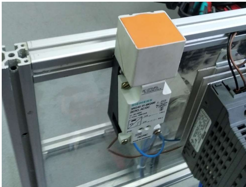
Figura 14. Instalación de sensor inductivo
