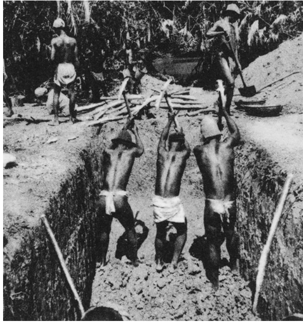
Figure 4.1 “Digging a trench in a gold-bearing placer.” Côte d’Ivoire, 1950. From Michel Bolgarsky, Étude géologique et description pétrographique du Sud-Ouest de la Côte d’Ivoire , planche photographique 10.
