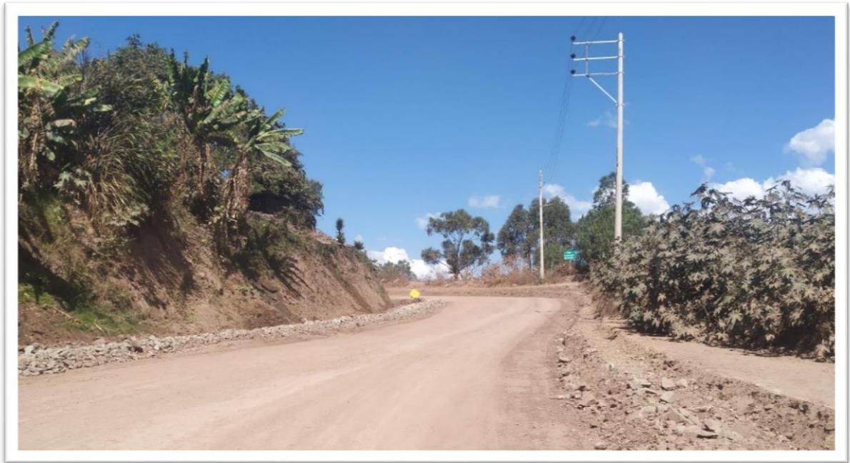
Tramo Km 04+30 con presencia de talud para realizar el corte de material suelto de acuerdo a los criterios técnicos del diseño de la vía de evitamiento de la ciudad de Abancay.
