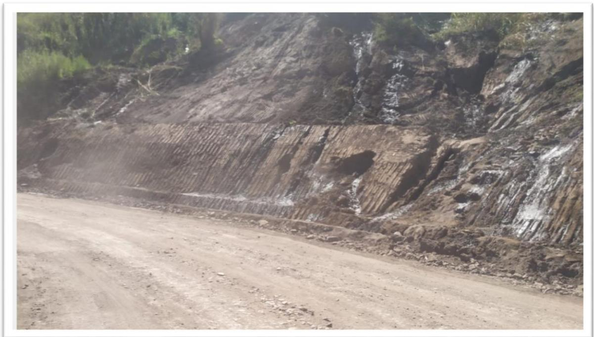
Corte de talud con banquetas de acuerdo al DG-2018 para estabilizar el talud de acuerdo a la tipología del terreno que se encuentra en el Km 06+50.
