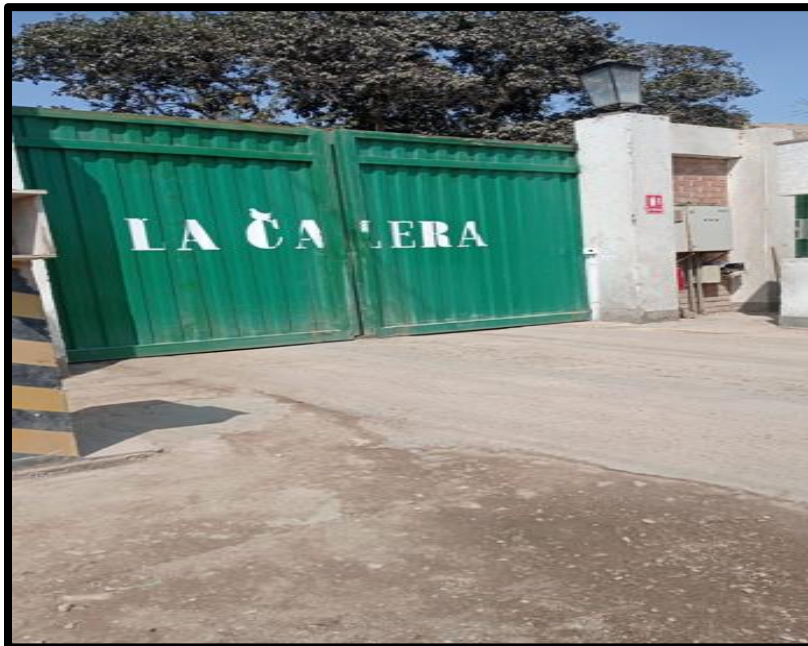
Figura 4. Entrada al área del almacén
