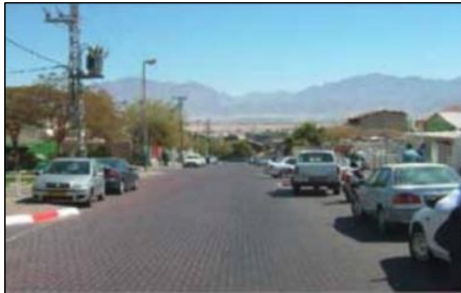
Figura 3: Pavimento adoquinado. Fuente: Echaveguren (2013).
