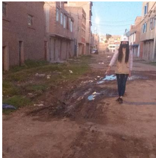
Figura 2. Fallas presenciadas en el Jirón Cuzco, intersección Jirón Bosque Fuente. Elaboración propia
