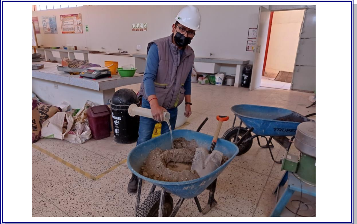
FOTOGRAFIA 07.- SE OBSERVA EL MEZCLADO Y PREPARADO DEL CONCRETO PARA LA ELABORACION DE FSPFCIMFNFS
