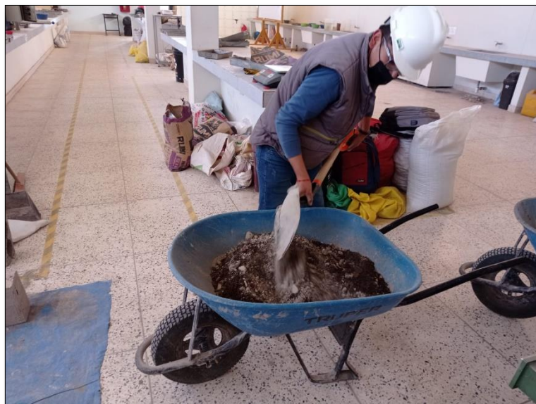
Figura 14. Mezclado y elaboración de concreto.
