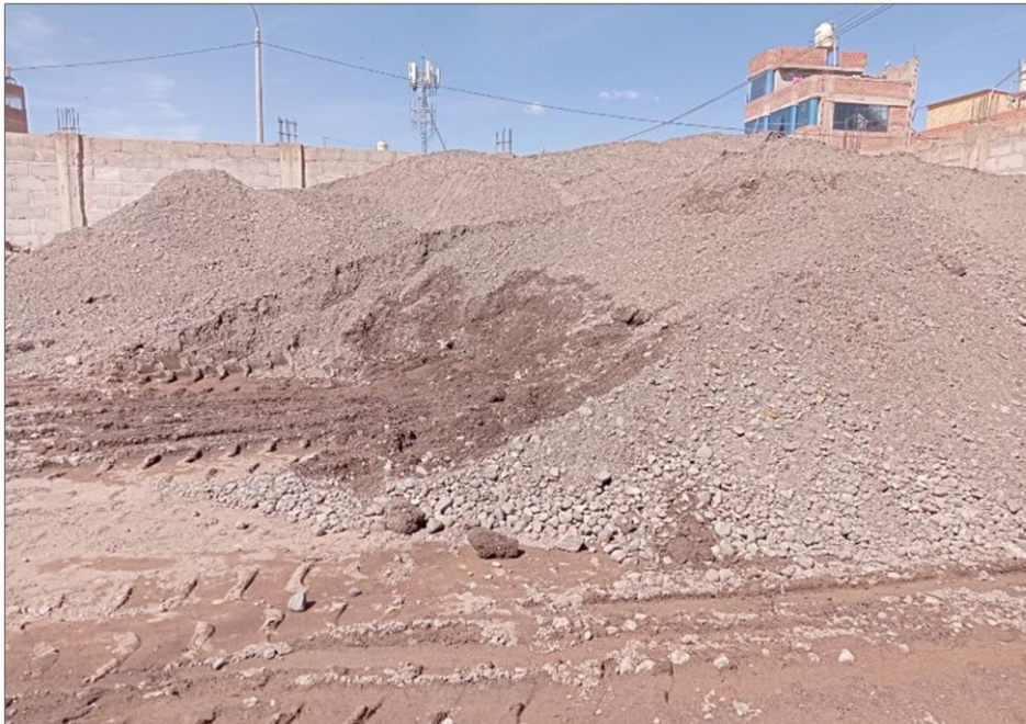
FOTOGRAFIA 01.- SE OBSERVA LA ACUMULACION DE AGREGADO DE LA CANTERA ISLA
