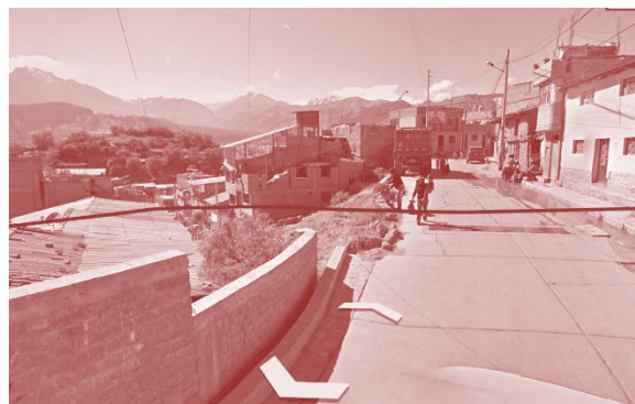
Figura N°11: Aspecto de la problemática del crecimiento urbano del barrio los Olivos. Fuente: Google Heart
