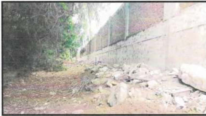
VISTA PANORAMICA N° 2 DE ZONA EN ESTUDIO
