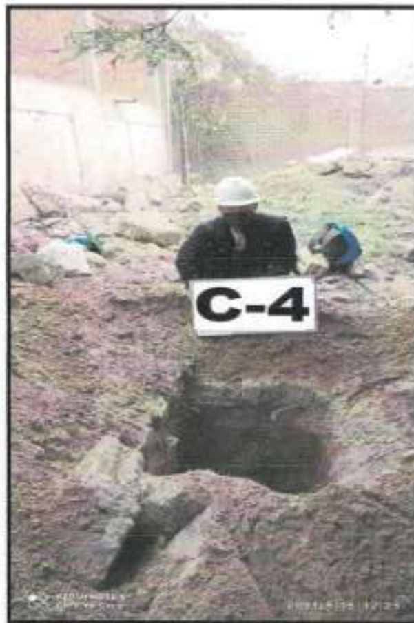
VISTA DE CALICATA C-4
