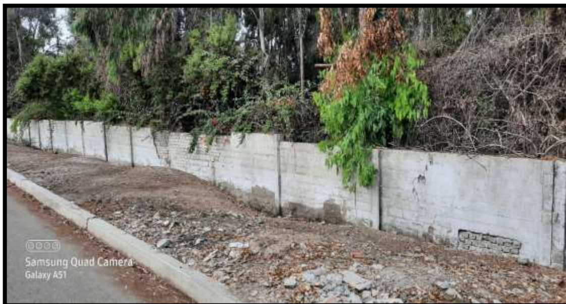
FOTO N° 01: Se aprecia el primer tramo del cerco perimétrico del Patrimonio Ecológico Cultural de Chimbote.
