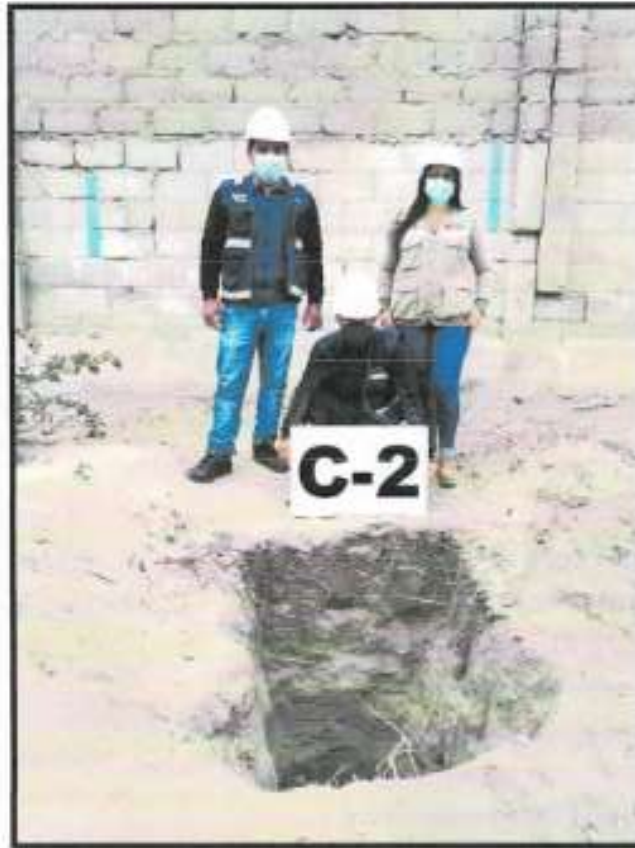
VISTA DE CALICATA C-2
