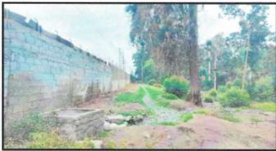
VISTA PANORAMICA Nº 1 DE ZONA EN ESTUDIO
