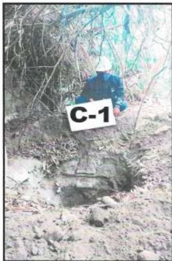
VISTA DE CALICATA C-1
