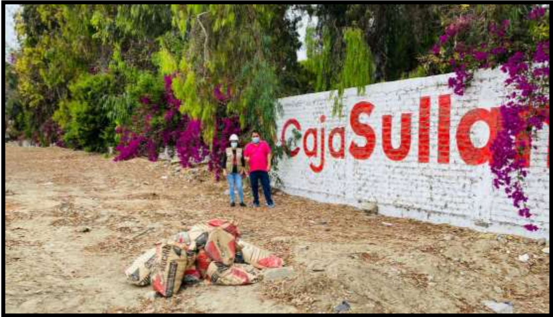
FOTO N° 03: Supervisión de las patologías encontradas en los elementos estructurales del cerco.
