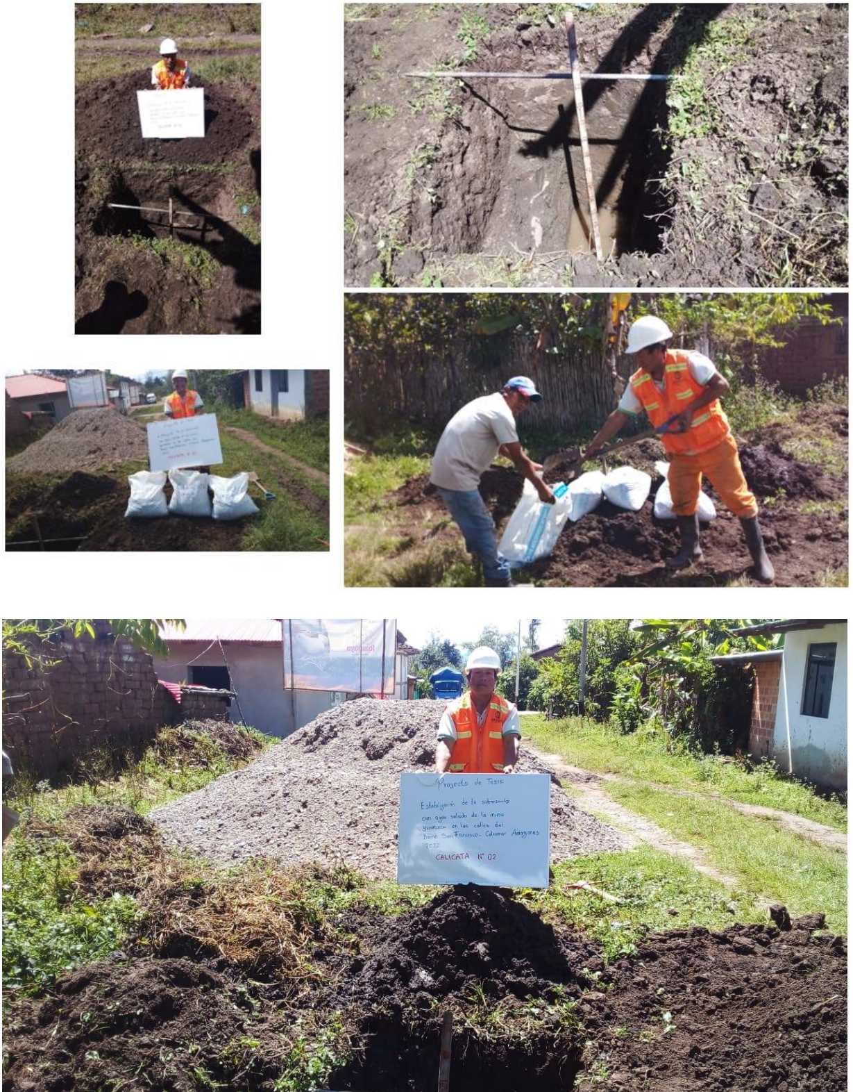
Figura 12. A continuación, los trabajos realizados en la calicata N° 02
