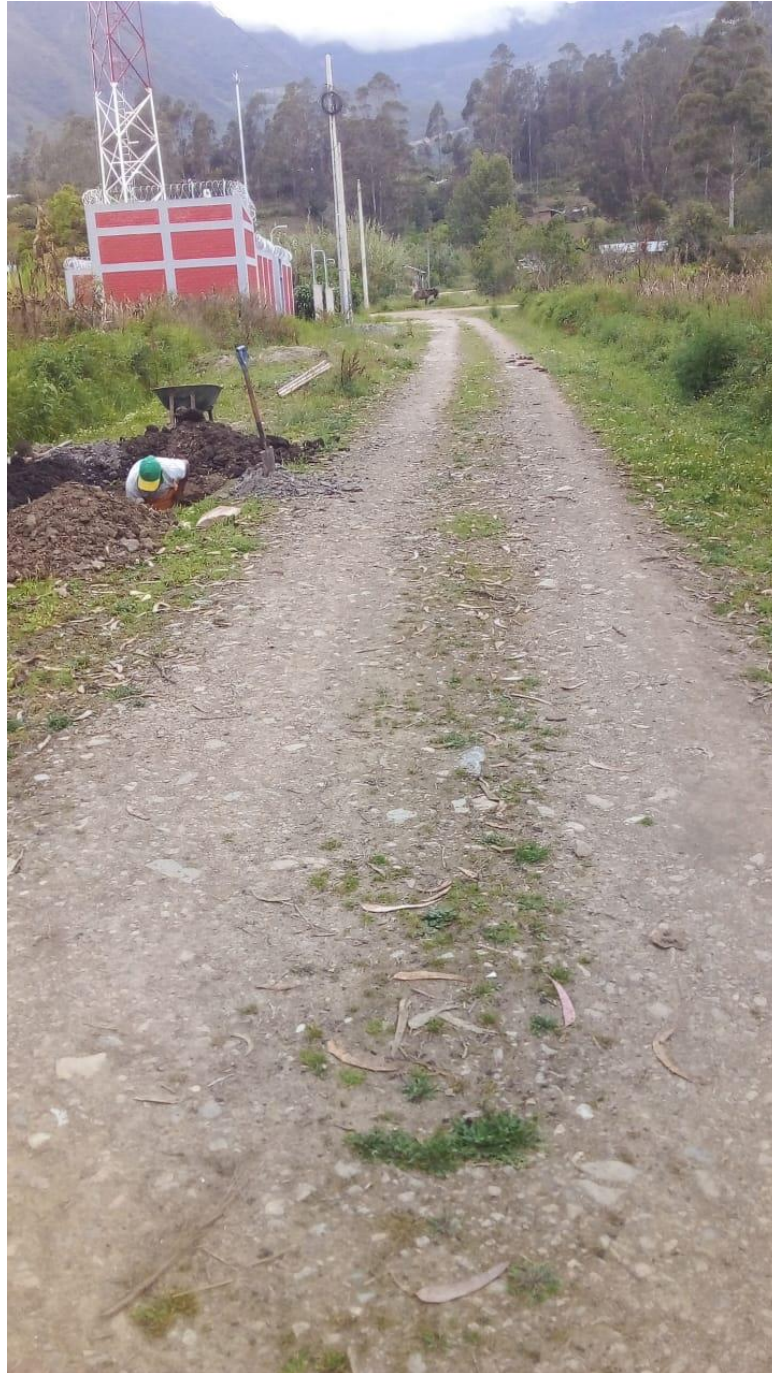
Fotografía 3. Calles del Barrio San Francisco donde se realizó la primera calicata
