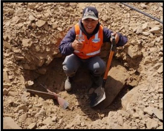
**IMAGEN 1:** se observa la excavación de calicata.
