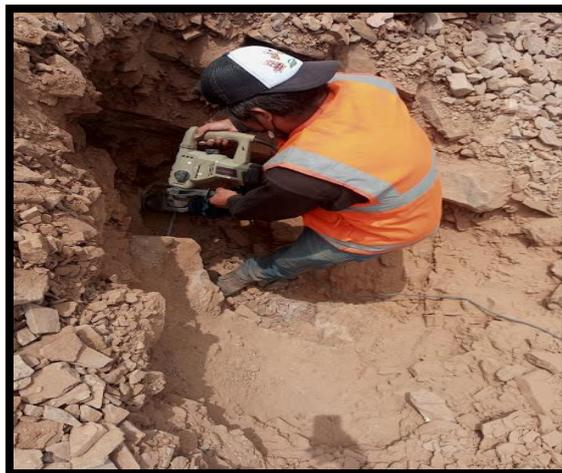
**IMAGEN 3:** se observa la excavación de la calicata.
