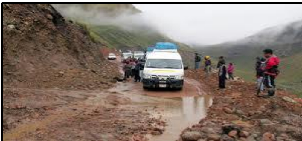
Figura 20. Estado de la vía que conecta umaca - sarahuarcay.
