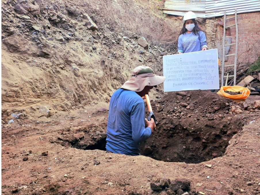
Figura 03: Apertura de calicata c-1 profundidad 3 metros como lo especifica la normativa.
