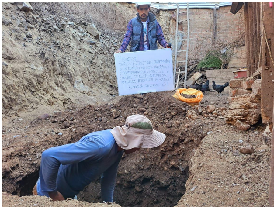
Figura 04: Apertura de calicata c-1 profundidad 3 metros como lo especifica la normativa.
