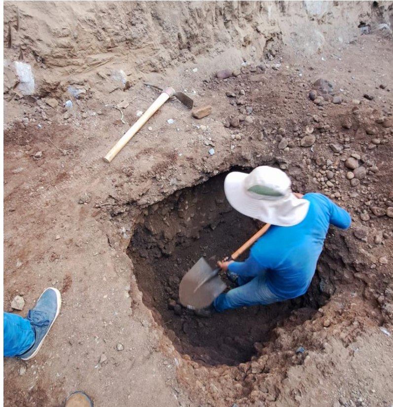
Figura 05: Apertura de zanja para estudio de suelos
