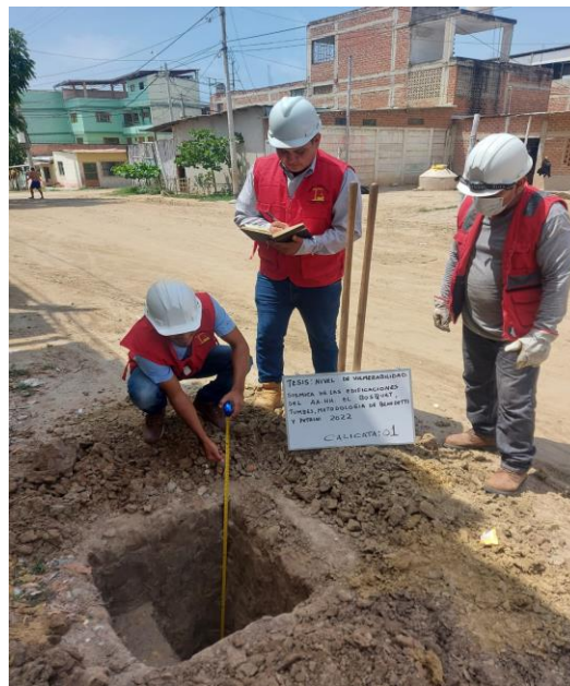
Figura 20: Tesistas midiendo profundidad de la calicata
