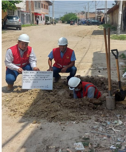
Figura 21; Tesistas verificando el cavado de la calicata C1
