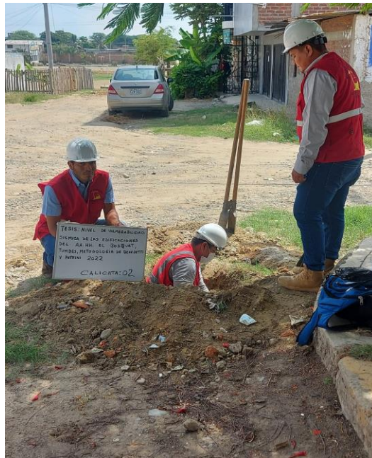
Figura 23: Tesistas verificando excavado de la calicata C2
