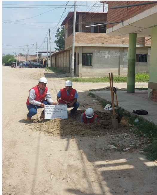
Figura 22: Tesistas verificando la elaboración de la calicata C1
