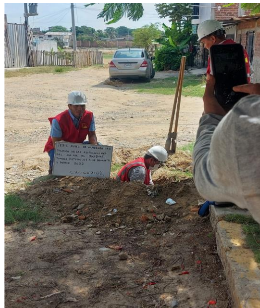
Figura 26: Excavado de la calicata C2
