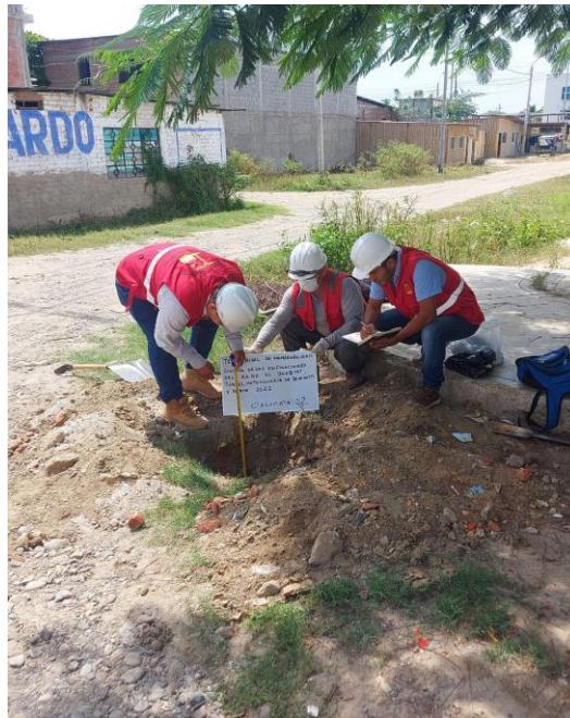
Figura 24: Verificando profundidad de la calicata C2
