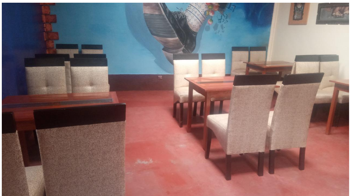
Comedor con piso de material no recomendado para la limpieza.
