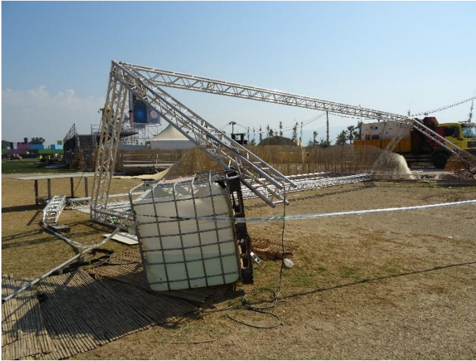
Figura 16. Zona principal de entrada al recinto, situada próxima al escenario principal, abatida hacia el sur-sureste.
