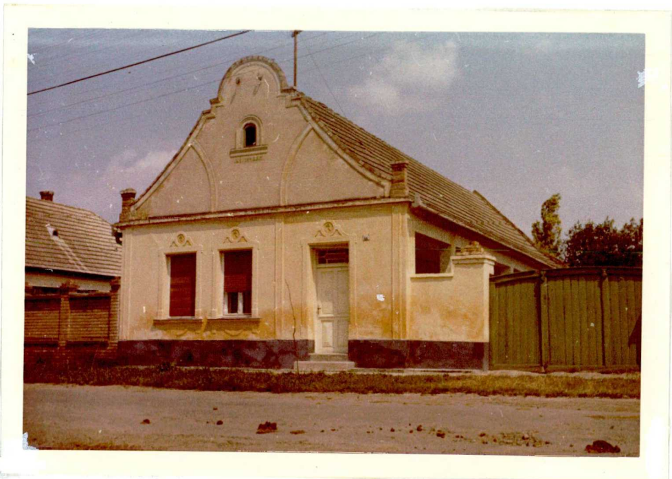
12.kép: Ivelt, nyeregtető fölé magasodó diszítés egy egy Kossuth Lajos utcai ház homlokzatán
