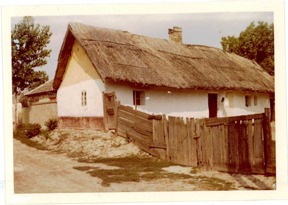
5.kép: Felmagasított térszínre épített ház a Dózsa György utcában
