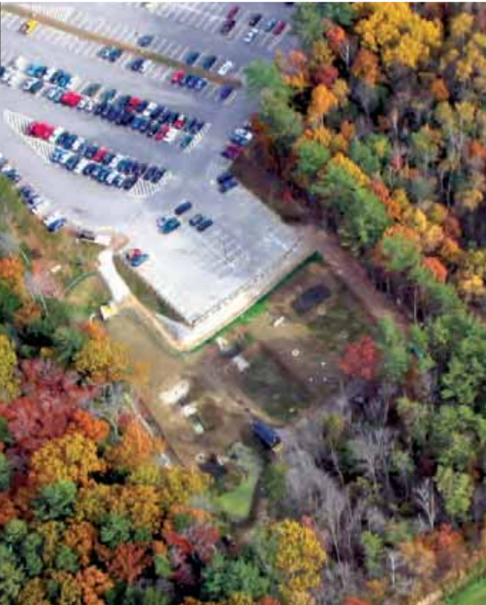
UNH Stormwater Center field site
