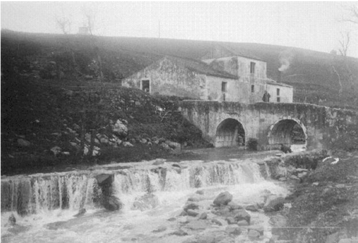
Vale de Alcântara — Junto à ponte do Tarujo, 1912 [Fonte: Arquivo Fotográfico Municipal]
