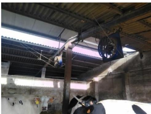
**Figura 6 - Ventiladores instalados no parque das vacas secas (foto original)**
