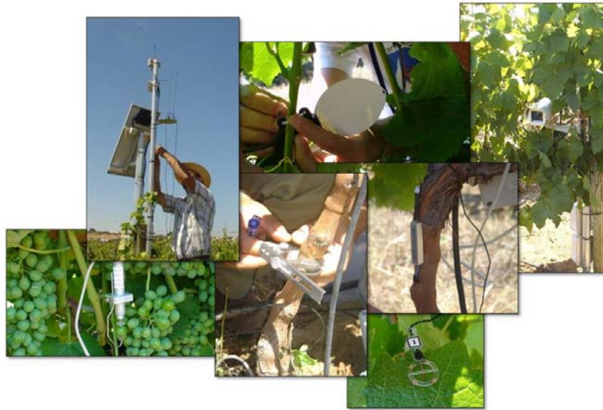
Figura 5. Imagens de alguns dos equipamentos instalados na i-Farm
