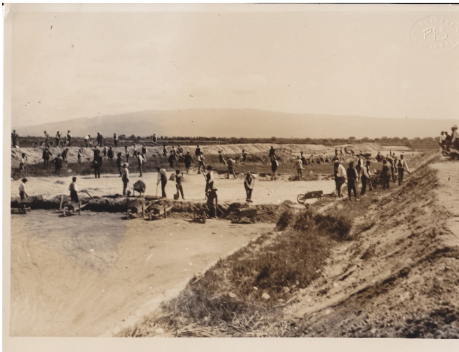
Foto 7 e 8. I cantieri della bonifica
