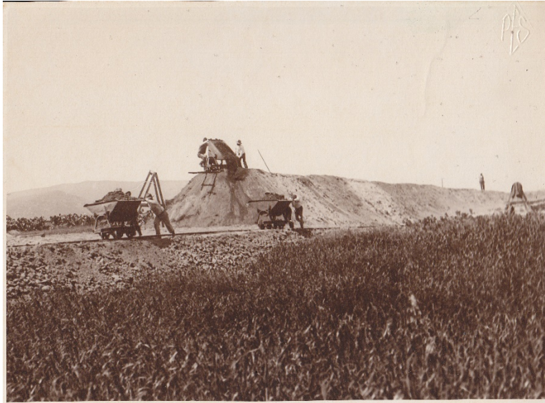
Foto. 5 e 6. I cantieri della bonifica
