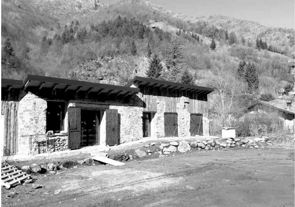
Fig. 3: Fasi di cantiere. L'edificio era privo di copertura e le parti integrate sono state rivestite da scorze di legno per renderle riconoscibili.
