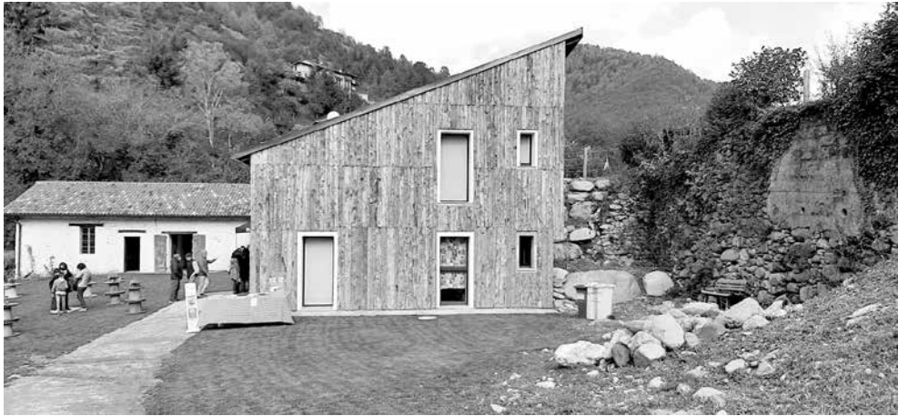
Fig. 5 In primo piano la porzione di edificio di nuova costruzione rivestita in legna e sullo sfondo la struttura ospitante il centro didattico. La superficie è stata trattata con latte di calce come era abitudine in zona.
