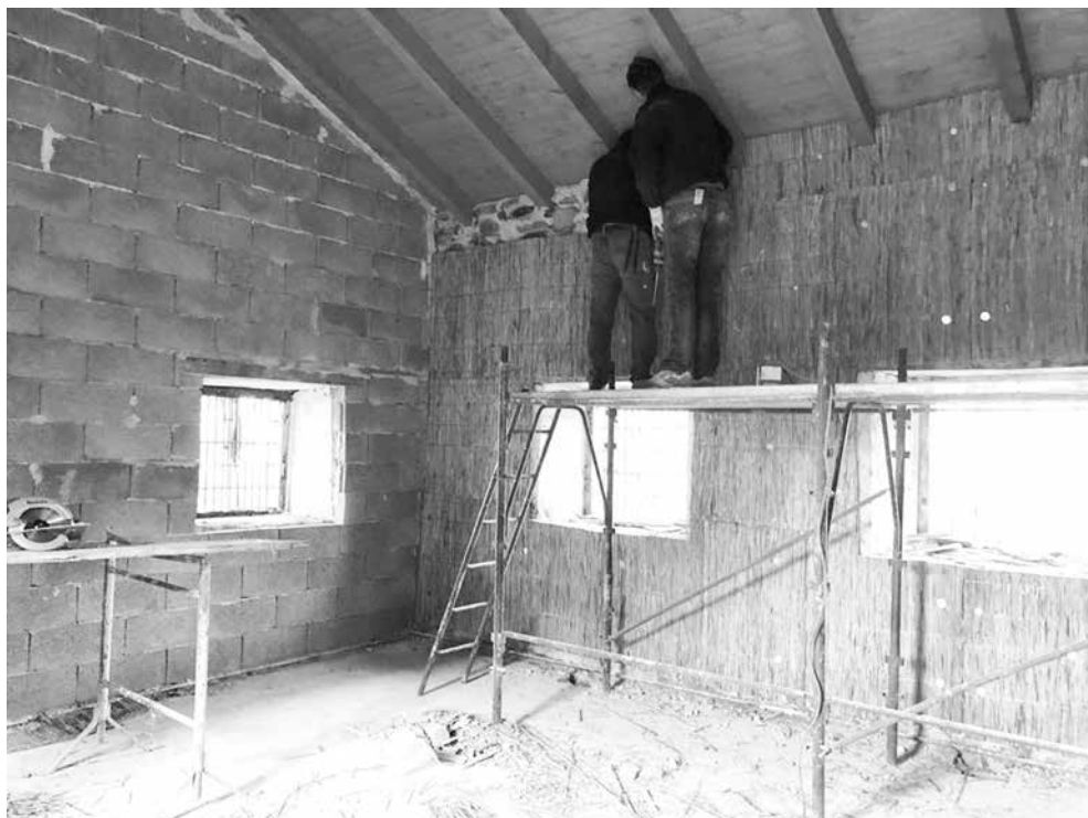
Fig. 4 Fasi di cantiere. Posa delle canne di bambù a isolamento della muratura. A sinistra sono stati collocati i mattoni di calce-canapa
