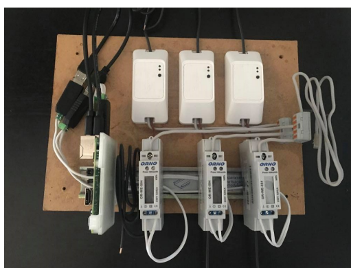
Figura 5.1: Instalação dos equipamentos adjacentes ao quadro elétrico.
