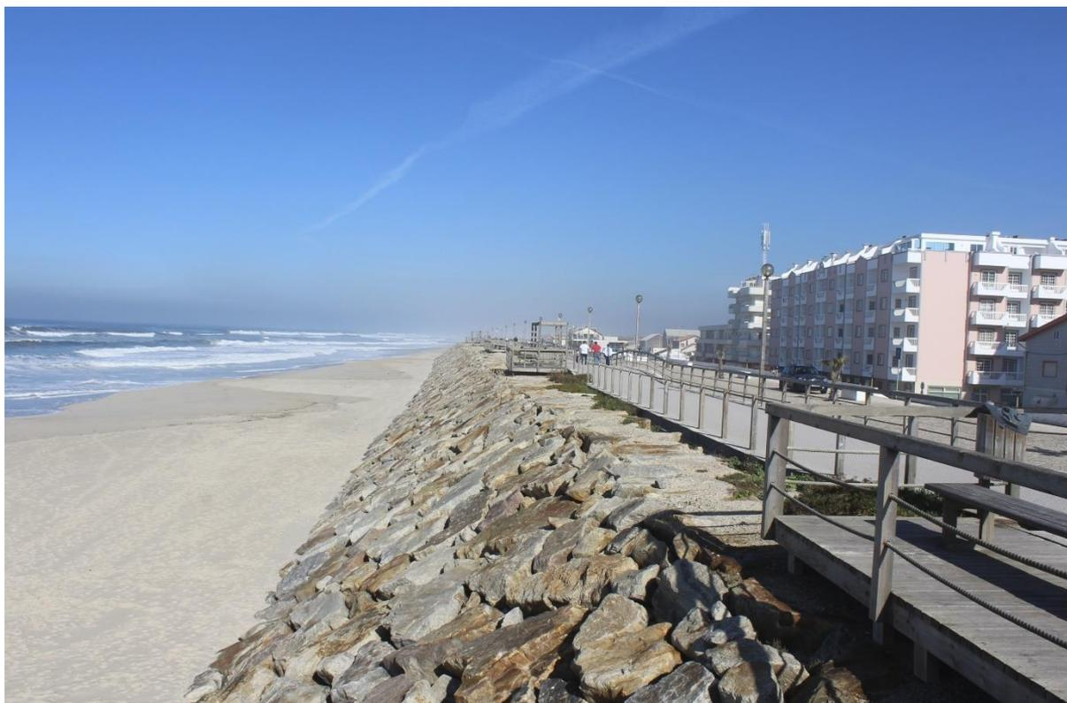
Figura 3.2- Fotografia da estrutura de defesa longitudinal aderente da praia da Vagueira (Vista para norte)
