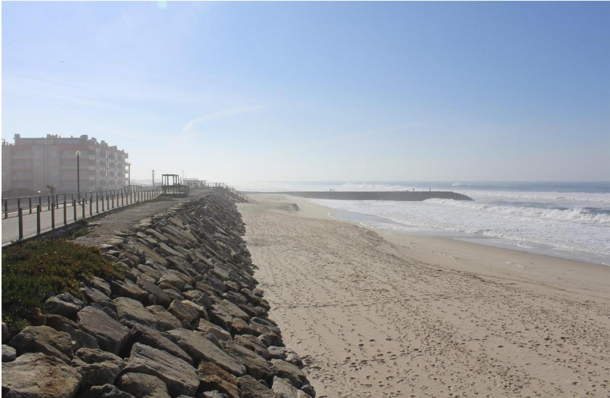
Figura 3.3- Fotografia da estrutura de defesa longitudinal aderente da praia da Vagueira (Vista para sul)
