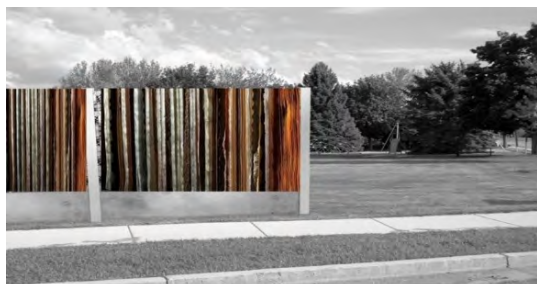
2. ábra. Zajárnyékoló fal 3D-s modellje: alapanyaga: fa, porcelán, kerámia, üveg [2]
