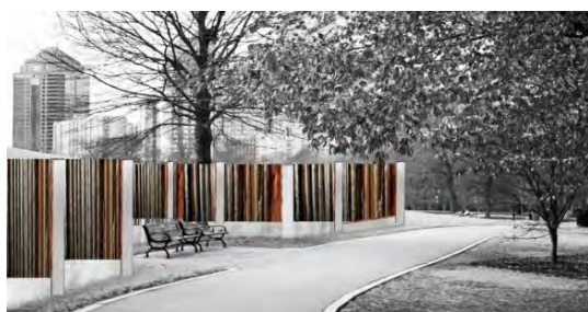
1. ábra. Zajárnyékoló fal 3D-s modellje: alapanyaga: fa, porcelán, kerámia, üveg [2]
